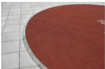
Vaalea betonilaatta ja leikkipaikan kumiasfalttipinta
