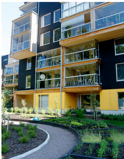
Puukerrostalorakentamista Eskolantiellä Pukinmäessä.
