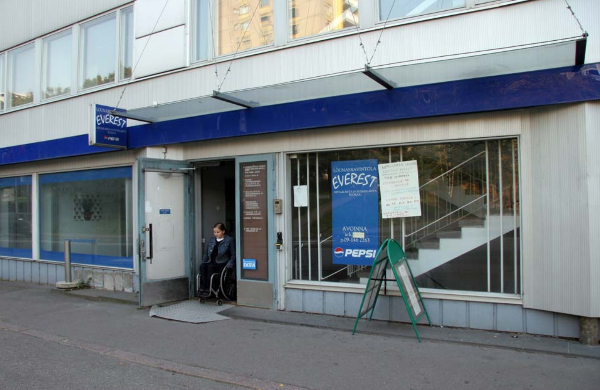
11. Jalkakäytävän tasoa on nostettu sisäänkäynnin edessä. Tasoero oli aikaisemmin noin 150 mm. Ovi aukeaa automaattisesti painonapista. (Kumpulantie 1)
