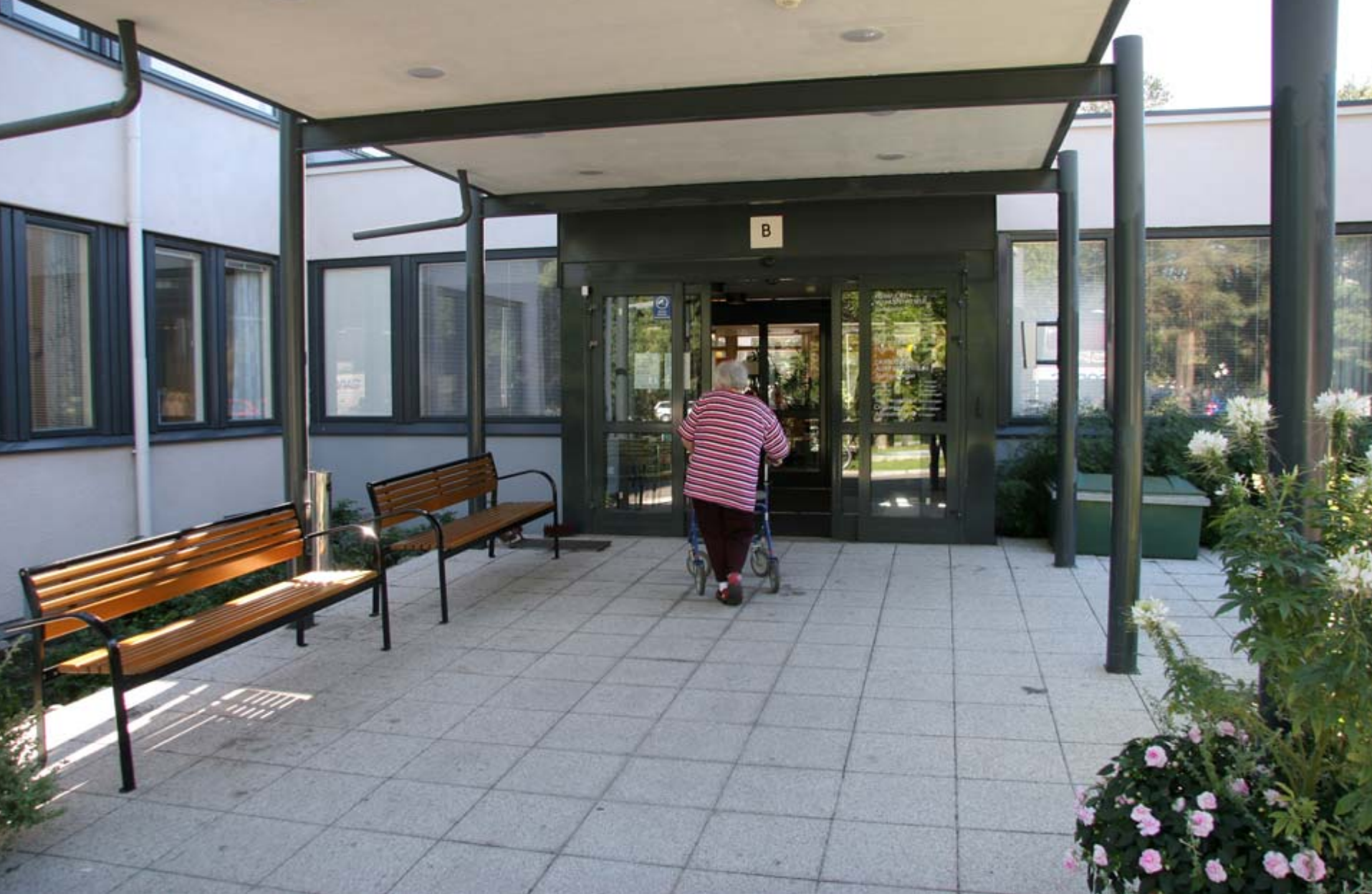
8. Sisäänkäynti on maan tasossa. Penkillä voi levähtää suojassa sateelta katoksen alla. (Riistavuoren palvelukeskus)
