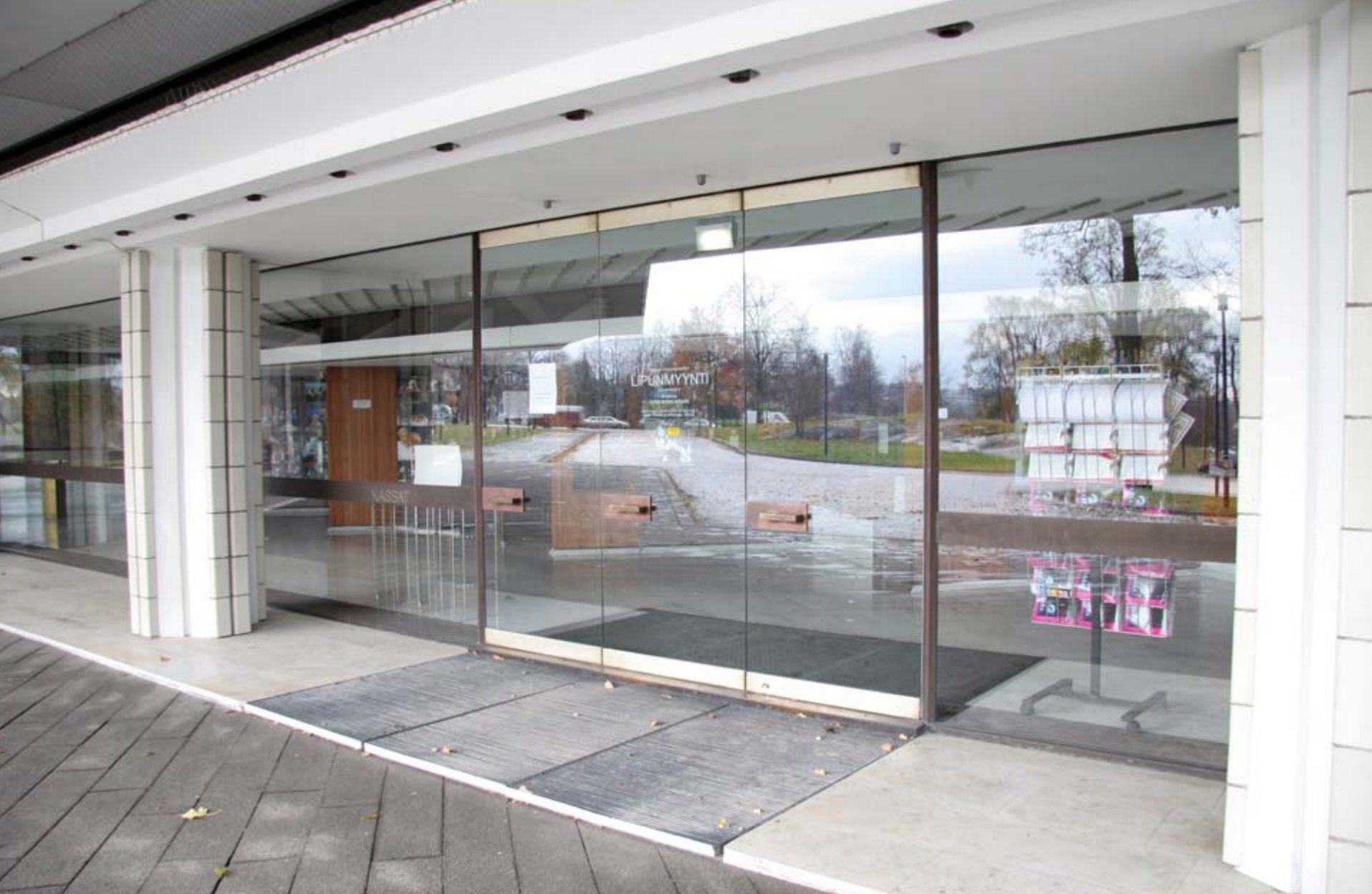
18. Sileä lasijulkisivu kiiltää ja on näkövammaisen henkilön hankala hahmottaa. Sisäänkäyntioven löytäminen on vaikeaa. (Helsingin Kaupunginteatteri)
