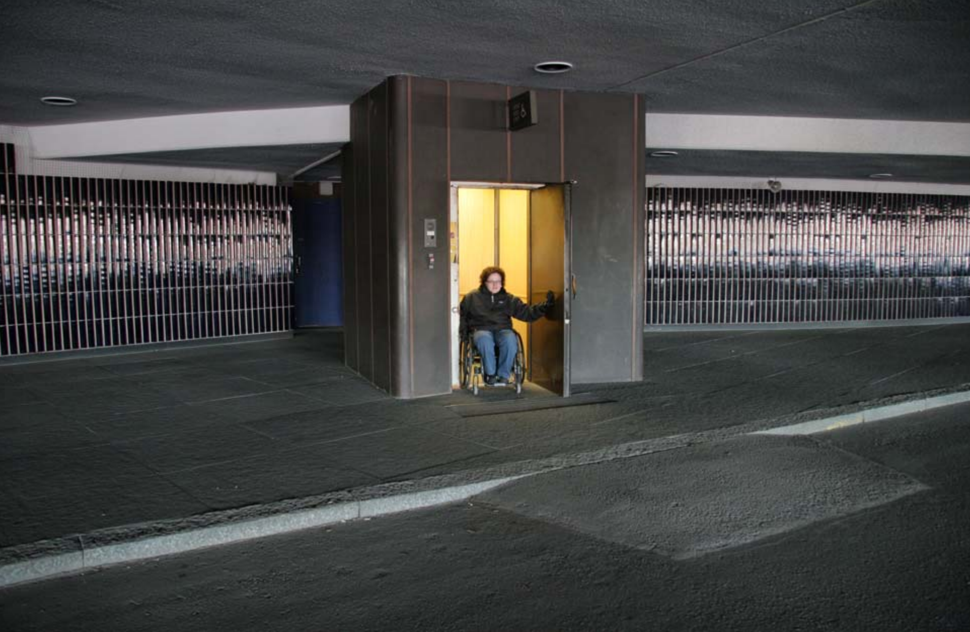
7. Sisäänkäynti on maan tasossa. Hissiin pääsee suoraan ulkotilasta. (Finlandia-talo)
