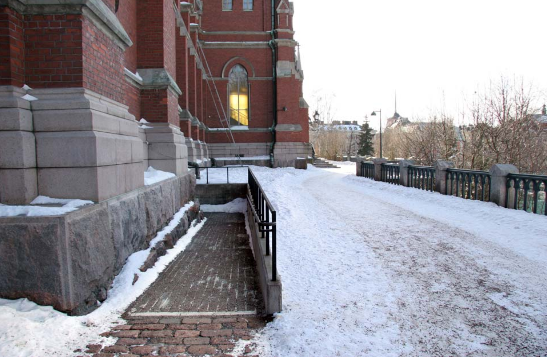
16. Alas johtava luiska ei muuta kirkon ulkonäköä kovinkaan paljon. Luiska on lämmitetty ja viemäroity lumen ja jään poistamiseksi. Kryptan tasolta nouseaan pyörätuoli hissillä kirkkosalin tasoon. (Johanneksen kirkko)
