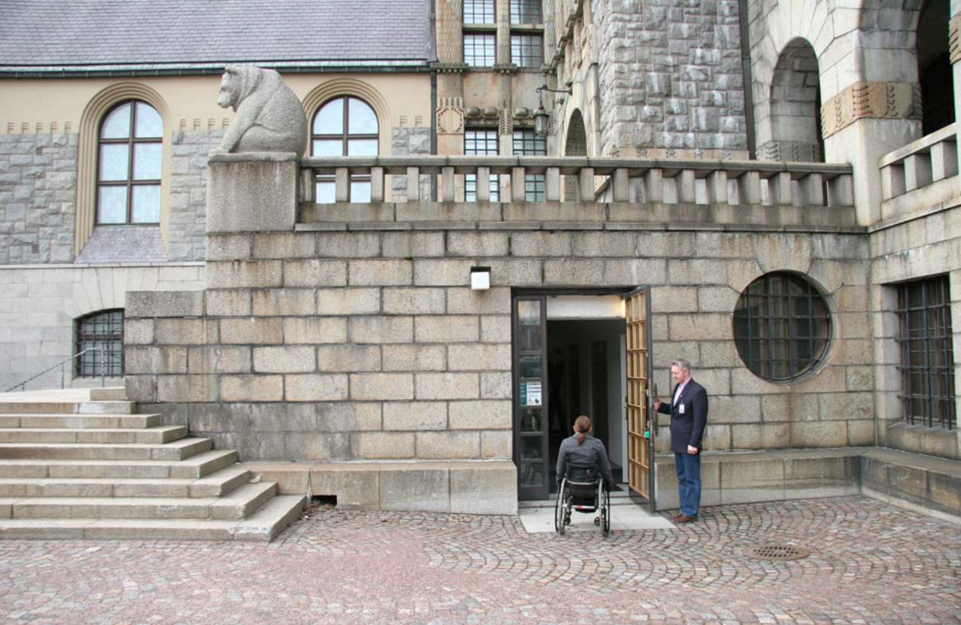
12. Pääsisäänkäyntiin on noustava kerroksen verran portaita. Uusi ovi on ennakkoluulottomasti avattu portaikon kylkimuuriin maan tasoon. Pohjakerroksesta päästään hissillä ylös. (Kansallismuseo)
