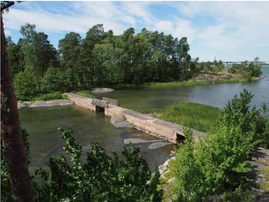
Nuottasaareen johtaa mantereen puolelta graniittinen, kunnostusta vaativa kävelysilta/kannas.
