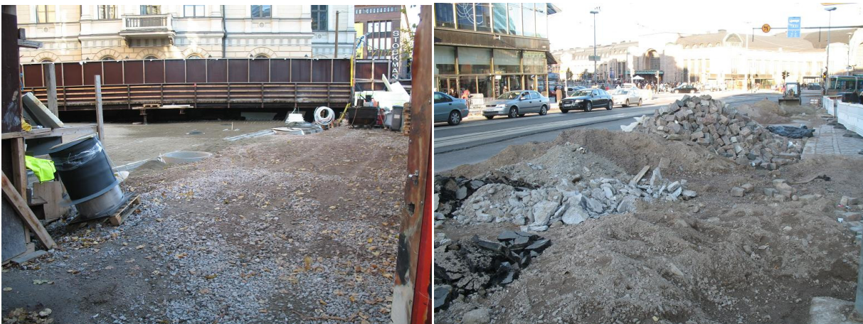
Kuva 2. Kaivopihan (vasemmalla) ja Kaivokadun (oikealla) rakennustyömaat lokakuussa 2008.
