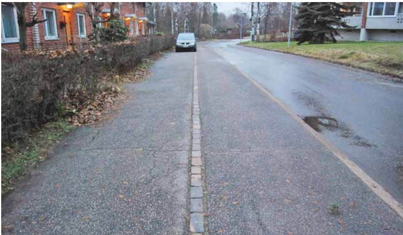
Koivikkotiellä tontti on erotettu katualueesta epätyypillisesti nupukiviraidalla.
