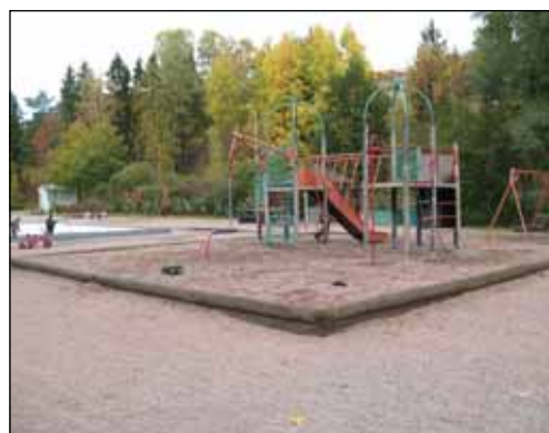
Leikkipuisto Salpausselkä kaipa kiireellisesti peruskorjausta.
