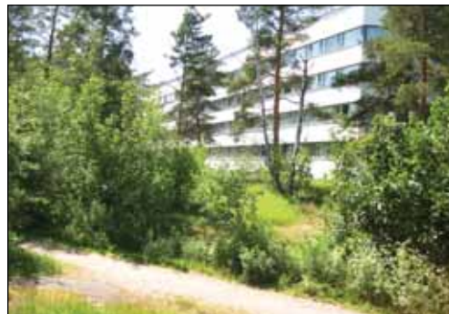
Ulkoilureittien varsien läheisyydestä poistetaan kuolleita puita.
