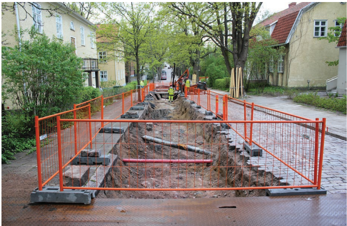
Kaivutöiden yhteydessä syntyvät juuristovauriot ovat puille erityisen vahingollisia. Kuva Tammitieltä. ML.
