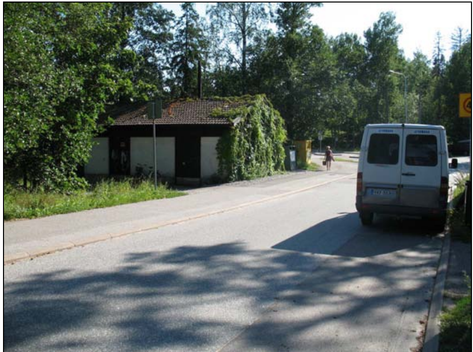
Kuva 27. Hevossalmentien ja Laajasalontien risteyksessä sijaitseva muuntaja.
