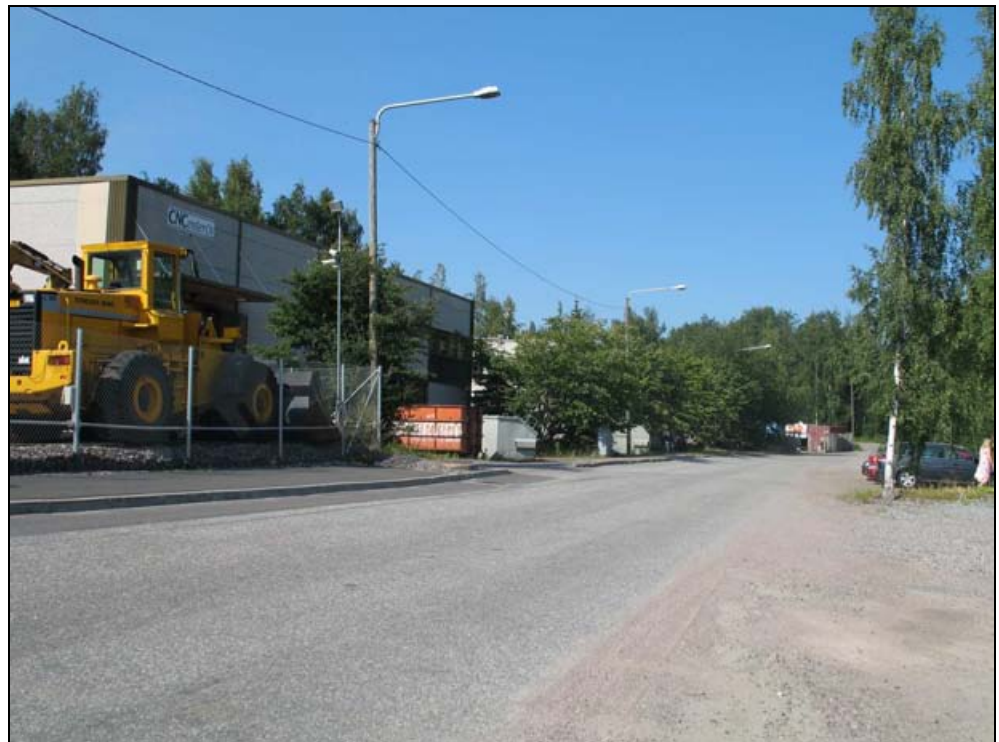
Kuva 13. Tulvatilanteessa vedenpinta nousisi Säynäslahdentien teollisuusrakennuksiin.
