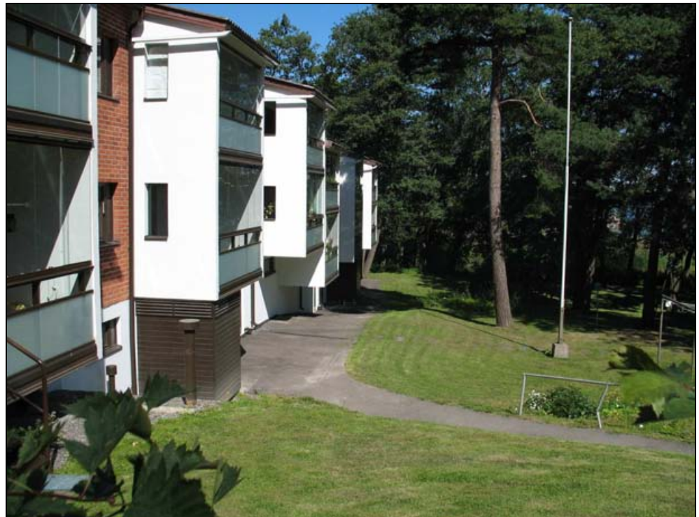
Kuva 5. Vesi pääsee Pohjoiskaari 29 kellarikerrokseen merenpuoleiselta alueelta.
