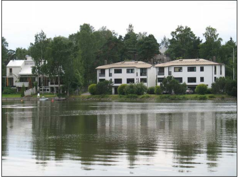
Kuva 17. Tulvatilanteessa vesi nousee rakennusten pihapiiriin (riskikohde 1).
