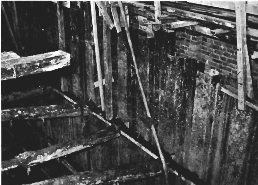
Kuva 90. Ponttiseinä 18.11.1958 rakennustyömaalla Kluuvikatu 4 (Helsingin kaupunginmuseon kuvakokoelmat).
