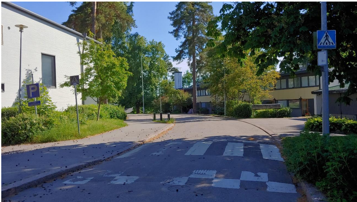
Kuva 7.14. Korotettu suojatie koulurakennuksen pohjoispuolella Paasitiellä.
