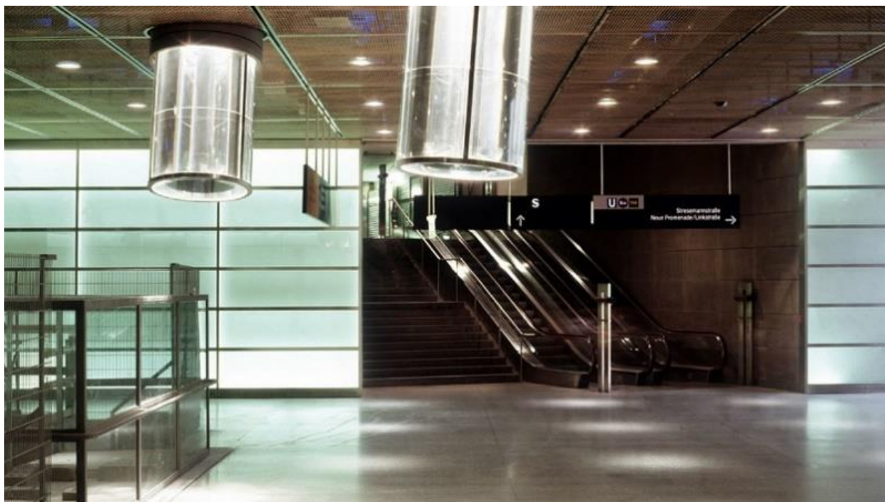
Kuva 42. Kolme "valoputkea" taittavat ja tuovat luonnonvaloa Potsdamer Platzin maanalaiselle asemalle. Kuvälähde: https://www.krapfag.ch/en/reference-projects/metal-construction/light-pipes-berlin-potsdamer-platz/
