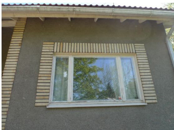
Yksilöllisenä piirteenä ikkunoiden ympärillä ns. ikkunapielet ovat puhtaaksi muurattua tiiltä. Jälleenrakennuskauden talon tyylikäs yksityiskohta.
