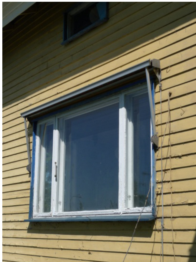
Alkuperäiset sirot puuikkunat kulmaraudoin ja ulkopuolisin saranoin
