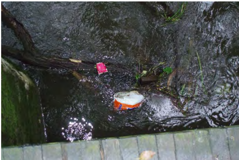
Kuva 20. Reitti 3c. Mätäjoen ylittävän sillan siltarumpuun takertuneita roskia.
