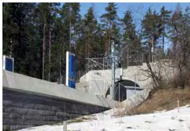
Kuva 20. Labbackan rautatietunnelin eteläinen suu vuonna 2009.
