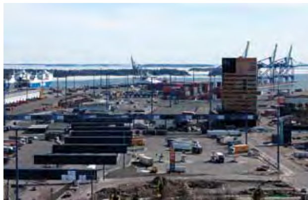
Kuva 25. Valmis satamakenttä vuonna 2009.
