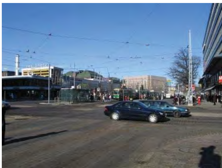
Kuva 14. Kalsiumkloridilla käsitelty kadun pinta näkyy tummana. Kuva: Jari Viinanen.
